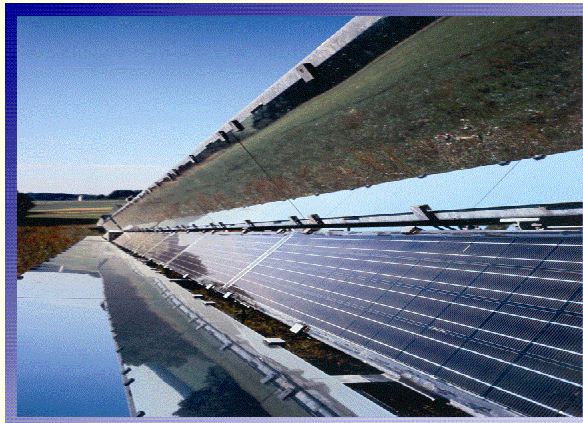
Photovoltaikanlage mit Strahlungskonzentration im Langzeittest
